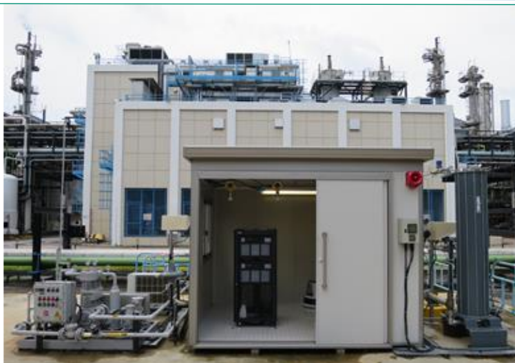
上圖: 煤氣公司位於大埔煤氣廠內的微型氫氣抽取系統
